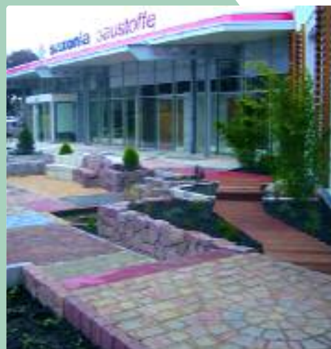
Mustergarten Saxonia Baustoffe - entstand in nur 7 Wochen Bauzeit, ca. 30 Betonbelege, 25 Natursteinbeläge, Natursteinmauern, Beton- und Natursteinstufen, Beregnungsanlage und ein Wasserbecken
